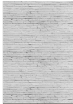
Muro Cantina SSMH020
